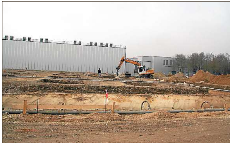
Die Bagger sind angerollt: Die Bauarbeiten an der Gottlieb-Daimler-Straße sollen im September abgeschlossen sein.
